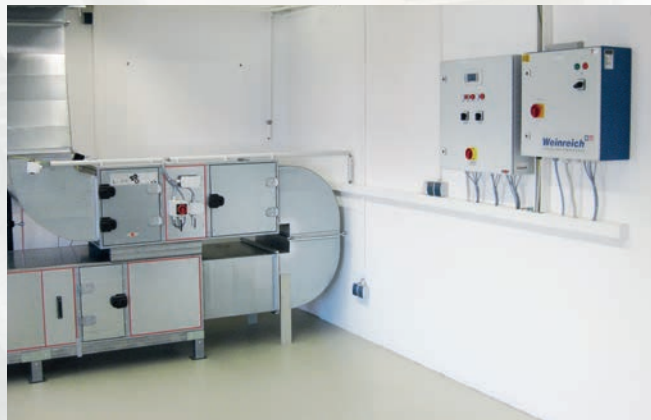
Heiz- / Kühl- und Filterelemente mit Steuerung
