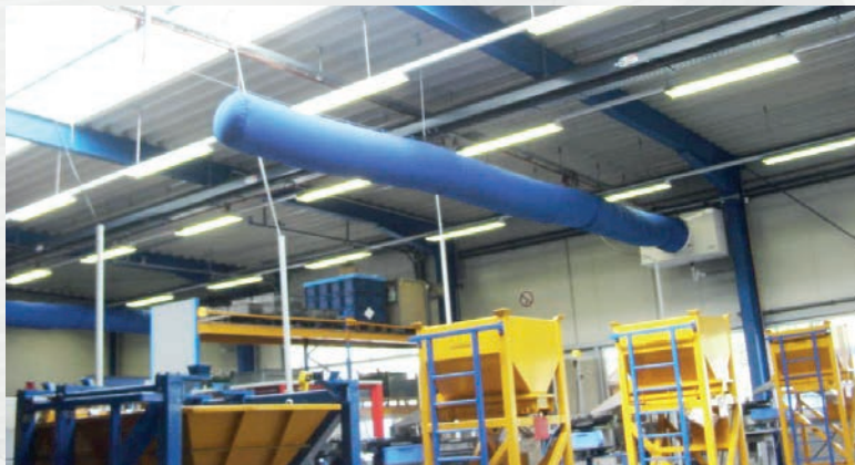
Textil-Luftschläuche zur gleichmäßigen Luftverteilung
